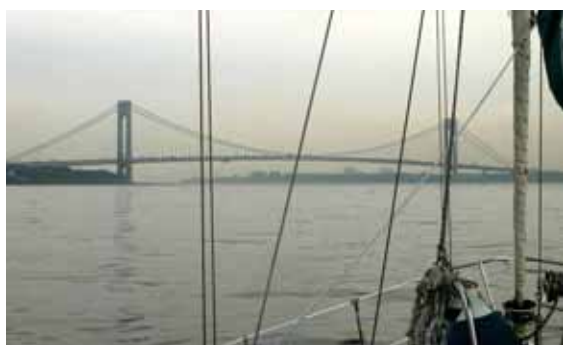
Le pont Verrazano, entrée de New York
